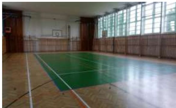
„ Oprava dřevěné podlahy v tělocvičně “ - srpen 2015
